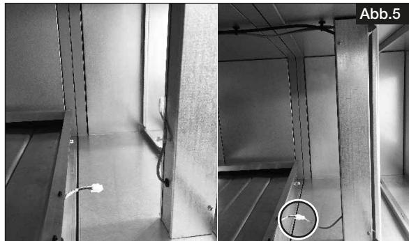
5. Das Umluftmodul mit den beiden Modulen des AIR1 RH-Lüftungsgeräts mechanisch verbinden, s. Abb.6.
