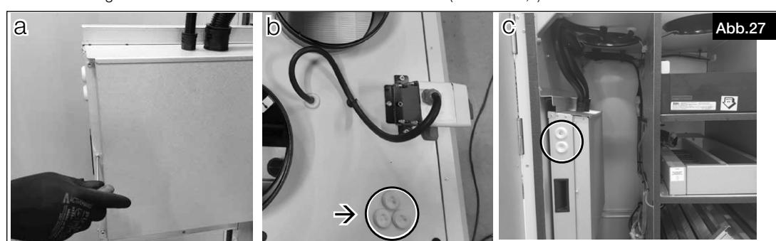
3. Steuerleitung des Bedienelements mit den markierten Anschlusspunkten (Abb.28) im Klemmenkasten anschließen (s. Anschlussplan).
