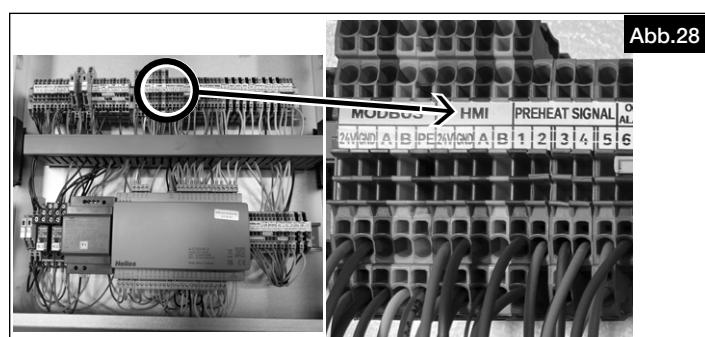
4. Das andere Ende der Leitung am Bedienelement anschließen (s. Anschlussplan).
