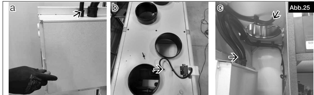
5. Kabel mit den markierten Anschlusspunkten verbinden (s. Anschlussplan).
