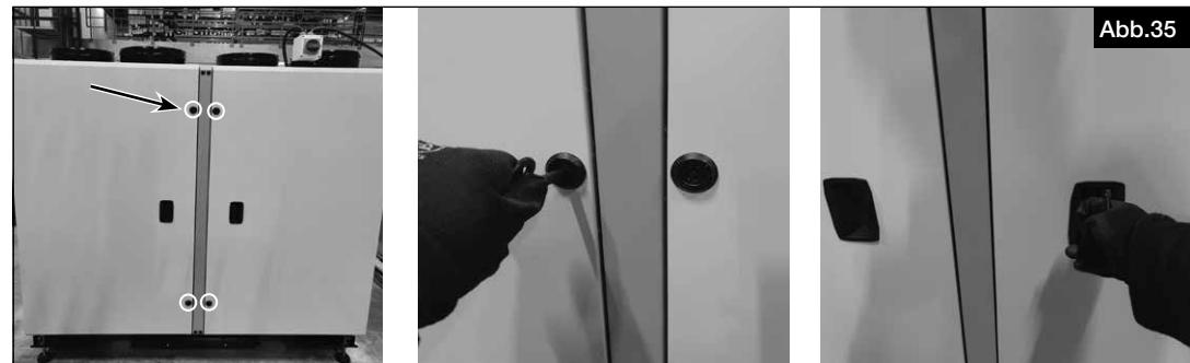
2. Das Profil muss für die Servicearbeiten am Wärmetauscher entfernt werden. Dazu die Abdeckungen entfernen und die Schrauben lösen (s. Abb.37).
