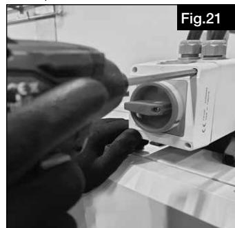
4. Desserrer le presse-étoupe et insérer le câble (câble d'alimentation et câble reliant l'interrupteur principal au boîtier de raccordement électrique dans l'appareil). Connecter le câble aux bornes entourées (voir schéma de raccordement) (voir Fig.22).
