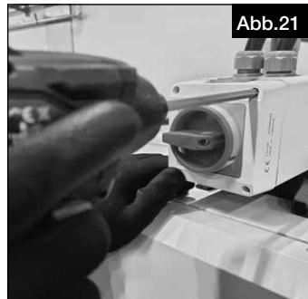
4. Kabelverschraubung lösen und Leitung (Versorgungsleitung sowie Leitung von Hauptschalter zu Elektro-Anschlusskasten im Gerät) durchführen. Leitungen an die Klemmen anschließen (s. Abb.22). Die Verbindungen sind dem Anschlussplan zu entnehmen.
