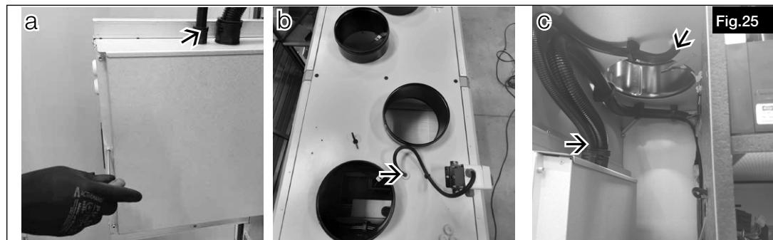
5. Connecter le câble aux bornes entourées (voir schéma de raccordement).
